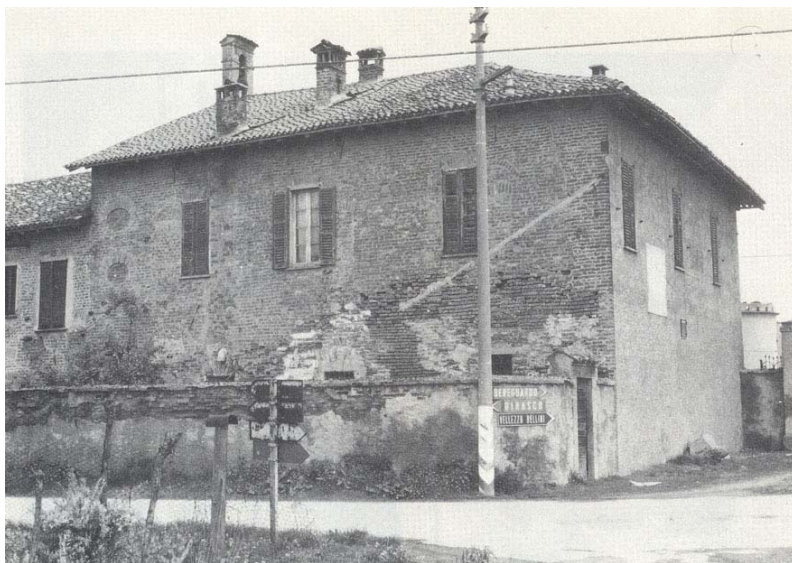
Rognano Facciata di ponente del palazzetto quattrocentesco, rivolta alla via. La muratura a vista che essa presenta è però solo in brevi tratti originale.
